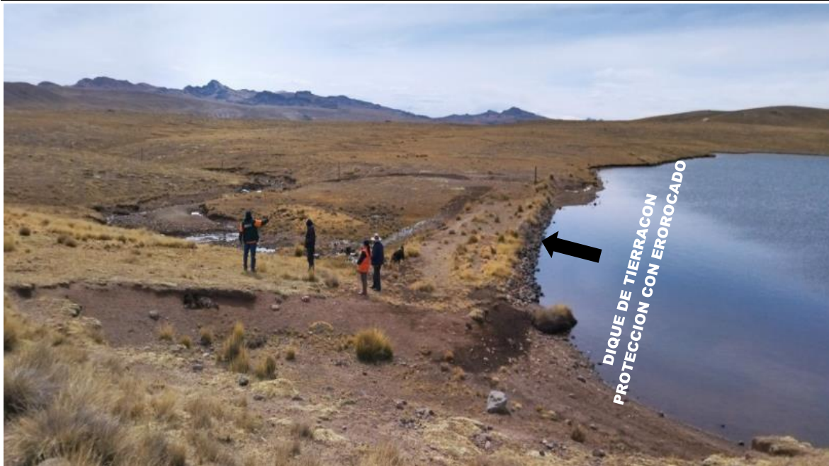
FIGURA N°01: VISTA PANORAMICA DE LA MICRO REPRESA CHILA PATA, DONDE SE APRECIA DIQUE CON MATERIAL PROPIO.
